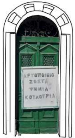
Σανιδωτή θύρα με ημικυκλική απόληξη (φεγγίτη με σιδεριά) και περιθύρωμα από πελεκητή πέτρα
