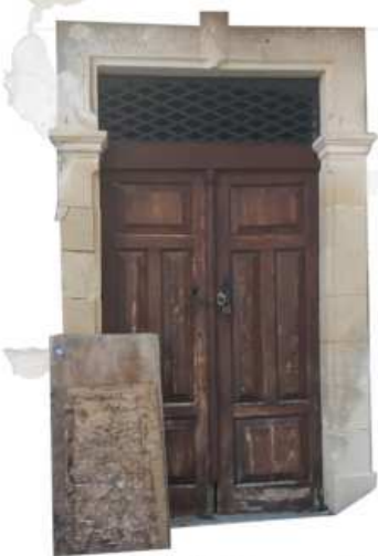
Νταμπλαδωτή θύρα με φεγγίτη και περιθύρωμα από πελεκητή πέτρα
